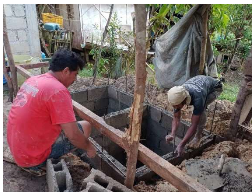
De septic tank wordt het eerst gemaakt
